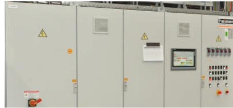
Abb. 9 Schaltschranksystem mit 21"-Touchpaneel
