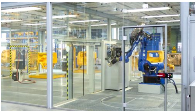
Abb.1 Blick in die mit Vollsichtelementen eingehauste Anlage, im Vordergrund rechts der Schleifroboter
