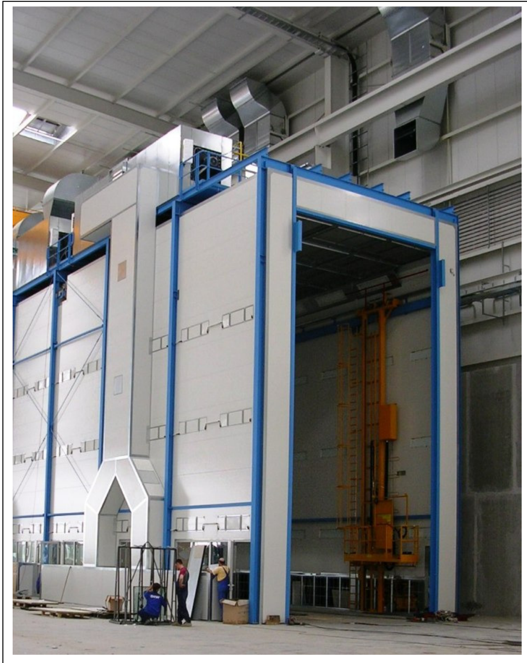
Montage einer Großraumlackier- und Trocknungskabine für die Finish-Lackierung von Hydraulikbaggern einschl. Wärmerückgewinnungseinheit
