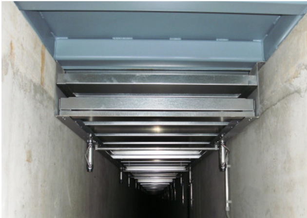
Abb. 2 Pneumatisch verstellbare Absaugsegmente
